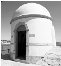
Casa abrigo do marégrafo de Cascais
