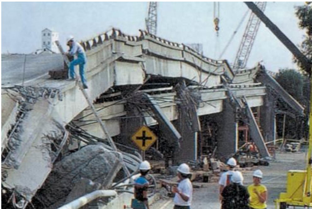
Fotografia da rodovia de Cypress Structure passando pela ponte Bay Bridge, Oakland, depois do terremoto Prieta, em 1989, que matou 42 pessoas ( USGS ).
